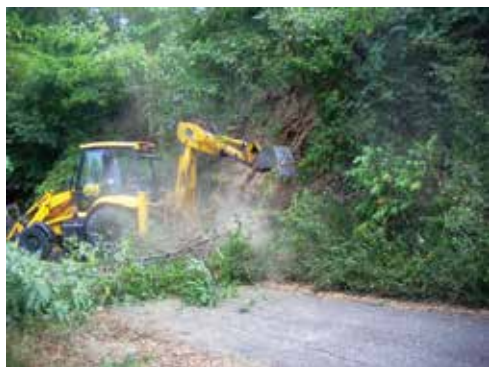
Профил у Буштрању: машинско одстрањивање непотребних слојева
