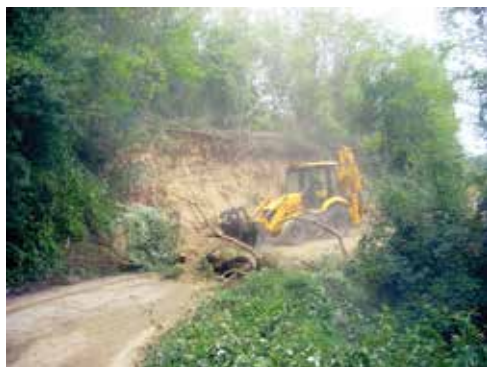
Профил у Буштрању: машинско одстрањивање непотребних слојева
